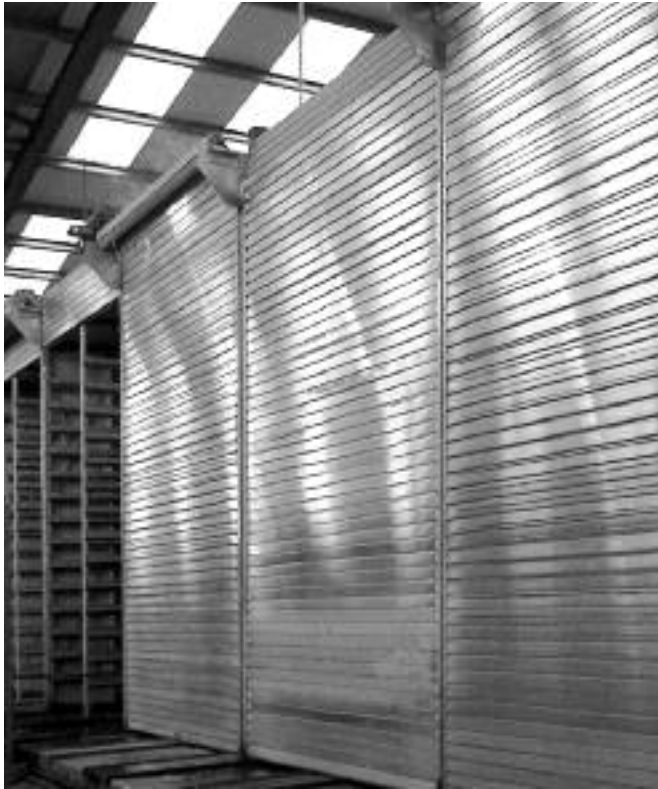
Камеры для сушки и затвердевания можно в любой момент оснастить шторными воротами
