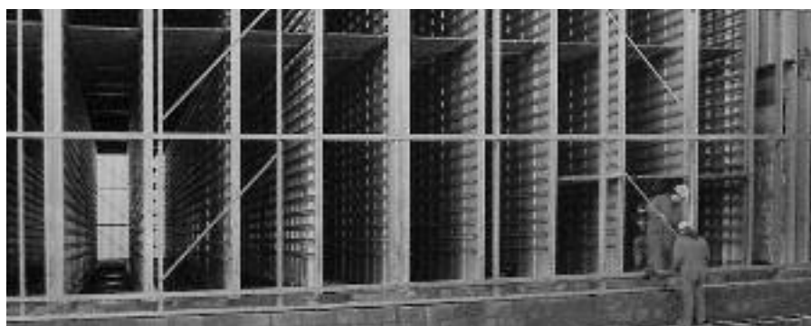
Стальной каркас цеха с камерой для сушки и затвердевания; обшивка устанавливается позже, монтаж не представляет проблемы
