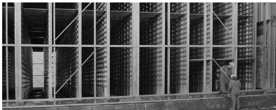
Scheletro in acciaio del capannone con camere di tempra ed essiccazione; il rivestimento viene montato in un secondo momento – Montaggio nessun problema
