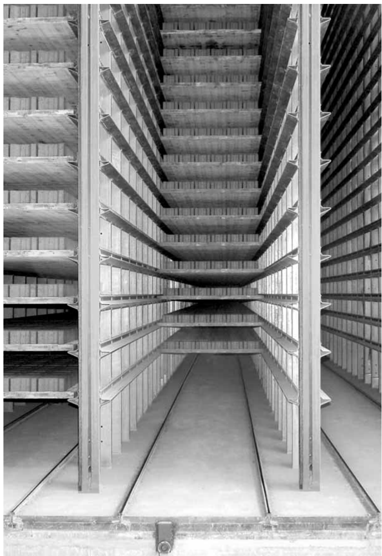
El resultado de un montaje exacto, ajustado y correspondiente a la altura, se puede apreciar.
