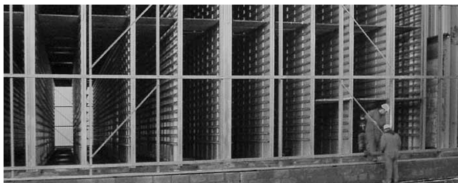
Estructura de acero del pabellón con cámaras de endurecimiento y desecación; el revestimiento se realiza posteriormente – Montaje sin problemas
