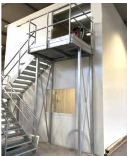
Schallschutzraum für eine Betonsteinmaschine
