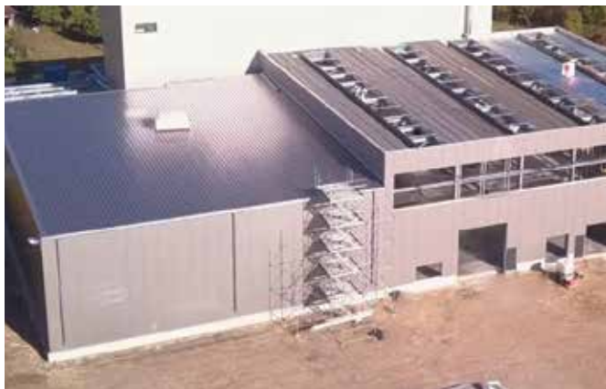
Kammerverkleidung einer Outdoor-Härtekammer
