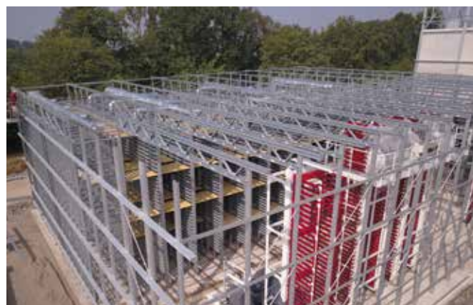
Stahlkonstruktion für den Schiebebühnengang mit einem Fachwerkdachträger
